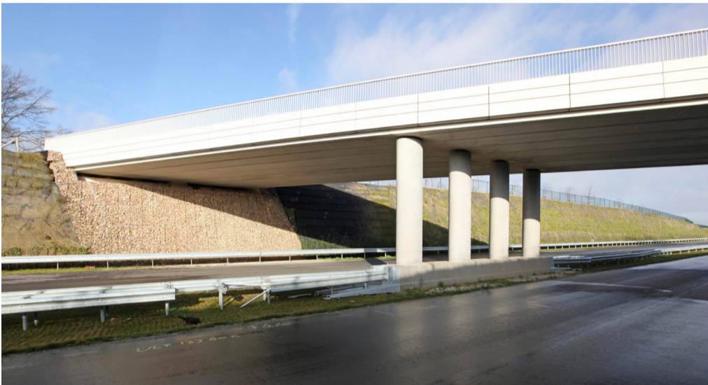
Referentiebeeld uniforme brugrand en spijlenleuning, slanke terugliggende steunpunten, geen zichtbare kesp, steenafwerking talud (brug buitenring parkstad Limburg)
