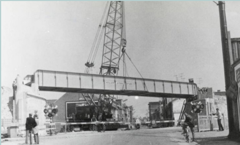
Plaatsing van de spoorbrug aan Vijfkameren
